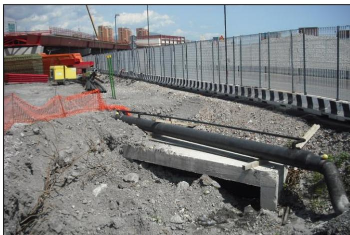
**Figura 9** – Foto della rete provvisoria metano DN 300
